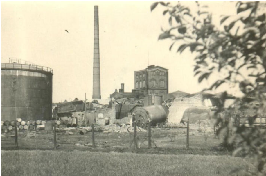
Große Teile der Spiritusfabrik sind zerstört, Foto: Archiv der FFW Krakow am See
